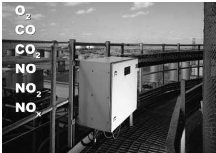
Анализатор мониторинга выбросов LAND, установленный на дымовой трубе
